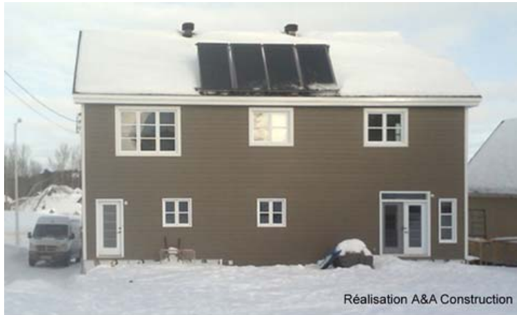
Cette maison en coffrage isolant obtient une cote Énergide de 90
